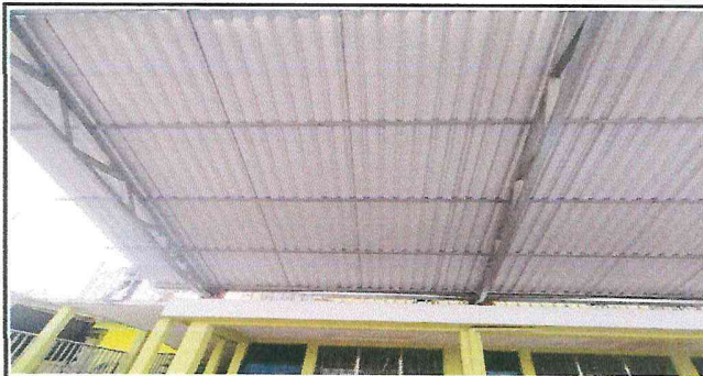
Foto 2: se sustituyo la estructura por nueva estructura de metal y lamina troquelada
