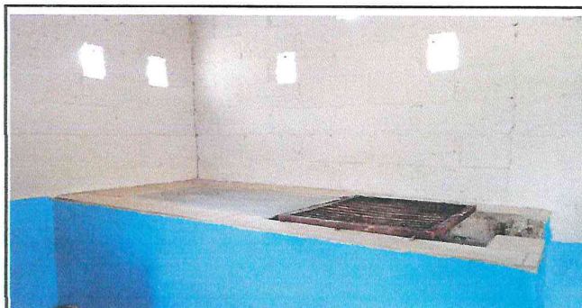
se sustituyo totalmente la plancha de la cocina por plancha nueva de metal
