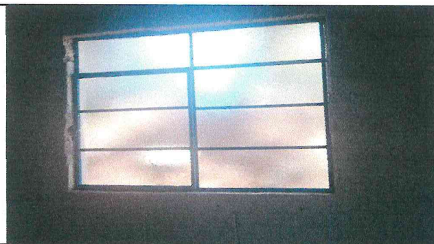
Foto 3: se sustituyeron vidrios de la ventana de la cocina como tambien se colocaron nuevos vidrios por los vidrios rotos y los espacios faltantes
