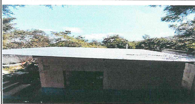
Foto1: Se sustituyo el techo por completo con lamina troquelada y estructura de metal
