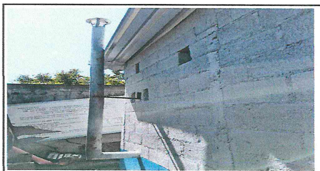
Foto 6: se coloco chimenea de metal en la parte trasera de la cocina para evitar que el humo se filtre en la parte interior y evitar que el humo se retenga en la parte interior
